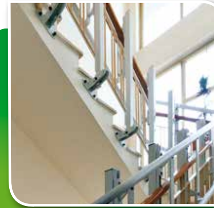
Fissaggio guida allo zoccolo della scala
