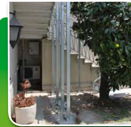
Fissaggio guida con pali lunghi da terra
