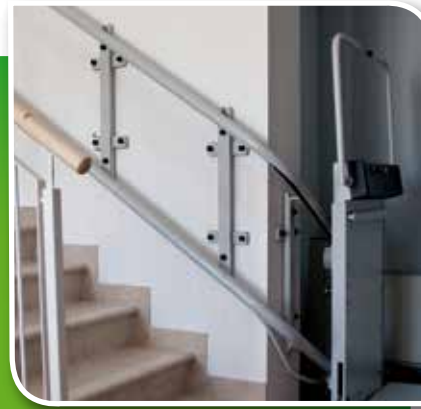
Fissaggio guida a muro
