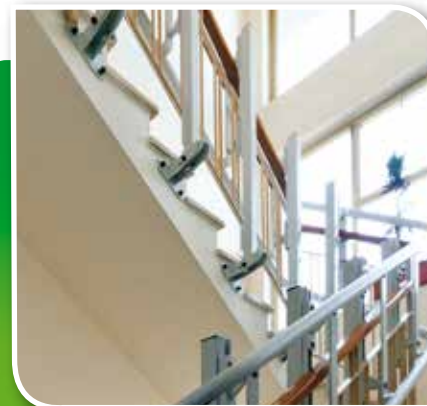
Fissaggio guida allo zoccolo della scala
