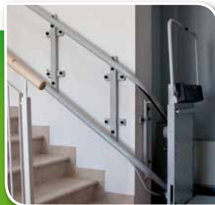
Fissaggio guida a muro
