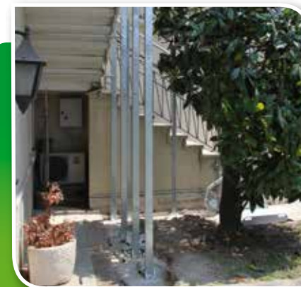
Fissaggio guida con pali lunghi da terra
